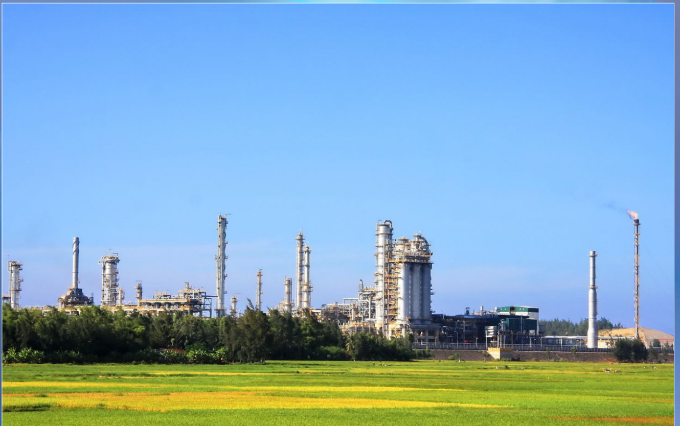
Nhà máy Lọc dầu Dung Quất
